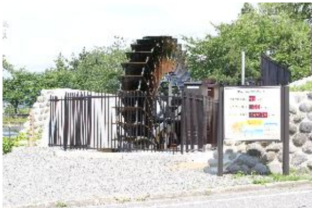
(常西公園小水力発電所)
