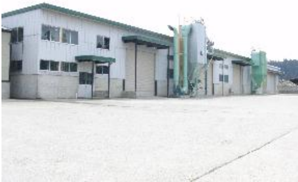
(製造施設外観)
