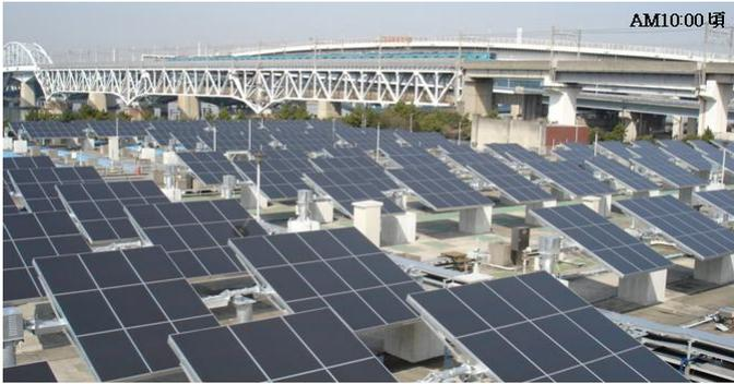
施設概要: \* 3836枚の太陽光パネルが490kwの電力を発電(一般家庭約160世帯分に相当)
